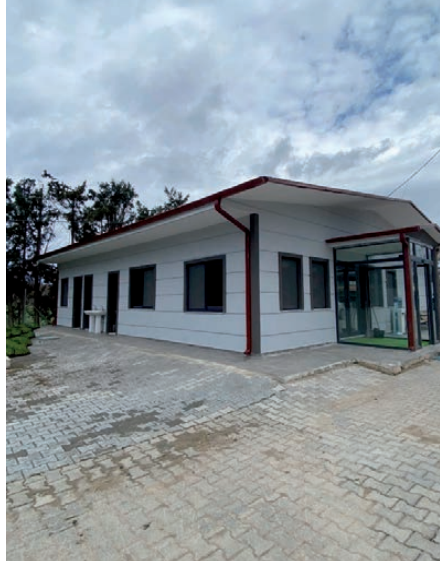
Park ve Bahçeler Müdürlüğü yerleşkesinde yapımı tamamlanan 2021/412459 ihale kayıt numaralı “İDARİ BİNA, ÇOK AMAÇLI BİNA VE KONTEYNER YAPIM İŞİ” (Wc, duş, yemekhane ve depo)
