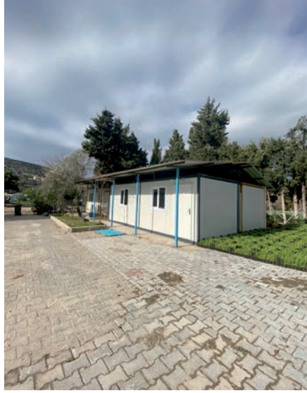
Park ve Bahçeler Müdürlüğü yerleşkesinde yapımı tamamlanan 2021/412459 ihale kayıt numaralı “İDARİ BİNA, ÇOK AMAÇLI BİNA VE KONTEYNER YAPIM İŞİ” (İdari Bina ve Teknik personeller için büro)
